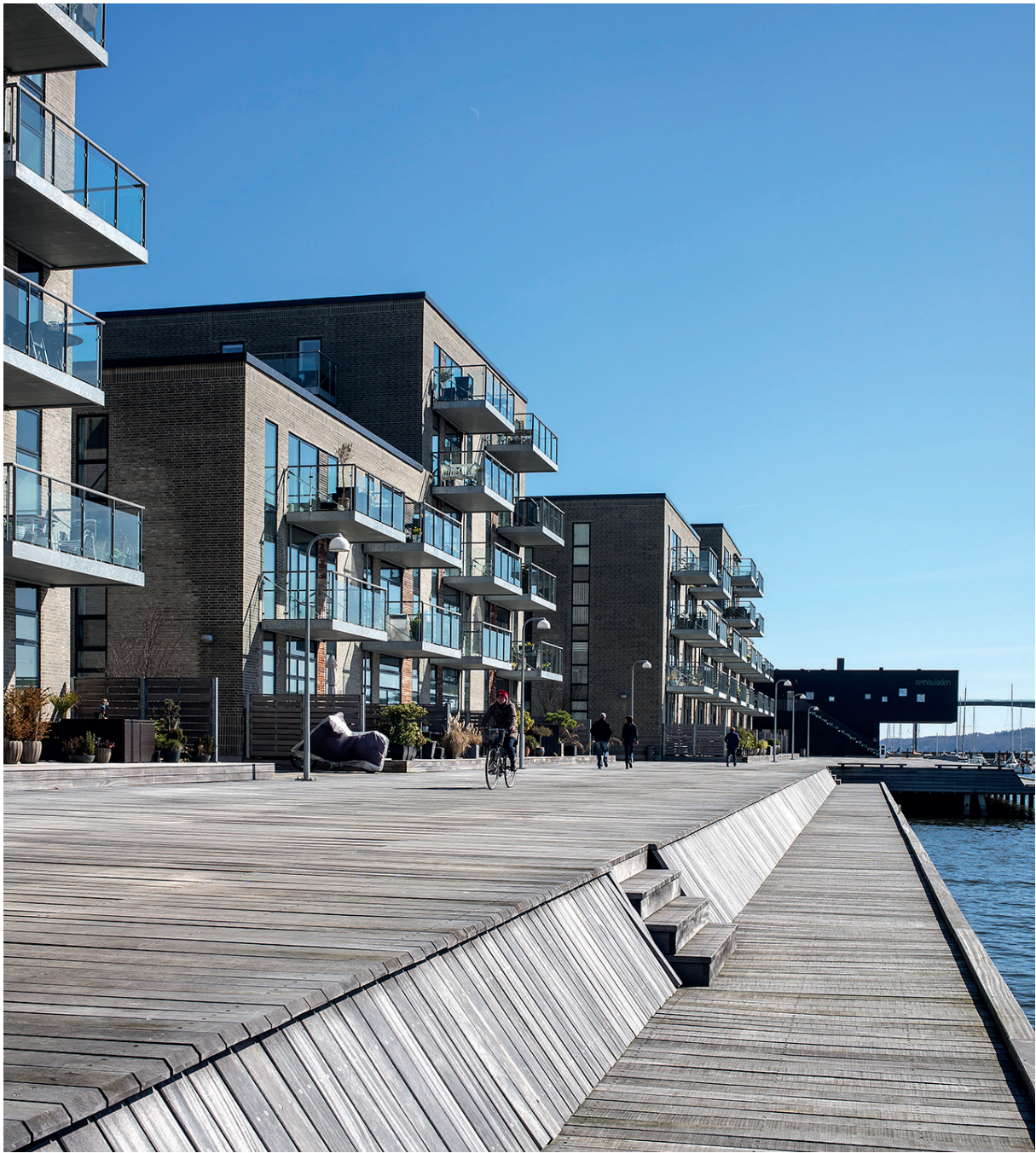
Uudisrakentamista entisellä Havneøenin satama-alueella Vejlessä Tanskassa. Kuva: Vejlen kaupunki
