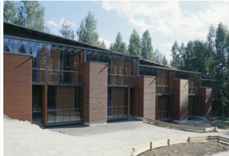
27. Hyvä arkkitehti nostaa vuokra-asumisen arvostusta esteettisellä otteellaan – ja taloudellisesti. Niiralan Kulmaa Kuopion Petosenkujalta Jarmo Pulkkinen suunnittelemana.
